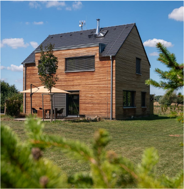
Realizace rodinného domu společnosti Alfahaus (www.alfahaus.cz)
